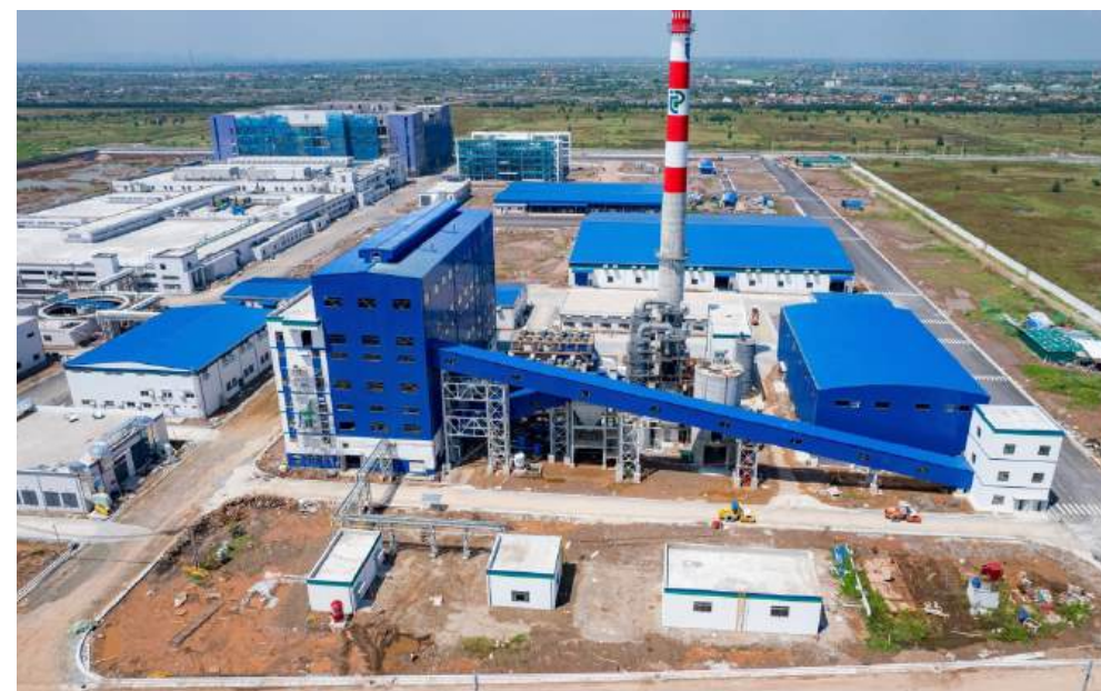
Dự án Tổng thầu EPC lò hơi CFB 3 x 35tph - Công ty TNHH Dệt Top Textiles
