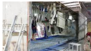
Hệ thống sơn tĩnh điện bột thủ công - Sử dụng lò sấy sơn di động
