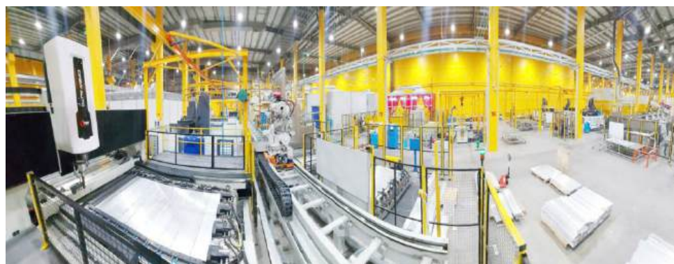
Dây chuyền hàn vỏ pin công suất 25.000 sản phẩm/ năm cho nhà máy sản xuất ô tô
