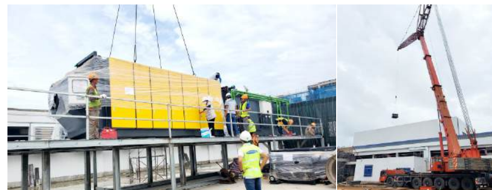
Dự án Lắp đặt dây chuyền công nghệ cho nhà máy dệt nhuộm Công ty TNHH TOPT Textiles
