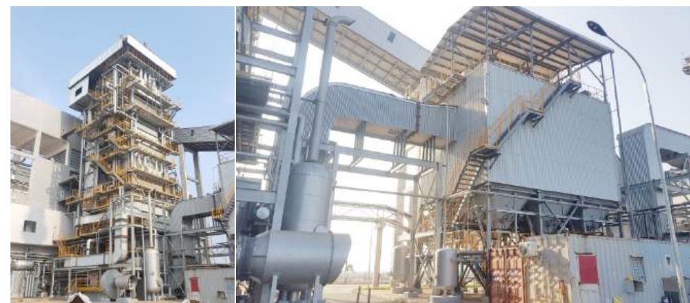
Thi công lắp đặt lò hơi và hệ thống phụ trợ cho hệ thống lò hơi 90 t/h. Công ty TNHH Khu Công Nghiệp Hải Hà - Quảng Ninh
