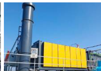
Lắp đặt dây chuyền công nghệ cho nhà máy dệt nhuộm
