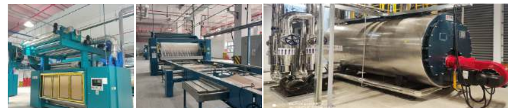
Công trình thi công lắp đặt hệ thống thiết bị tại Xưởng hoàn tất - Nhà máy TOP Textiles - Nam Định
